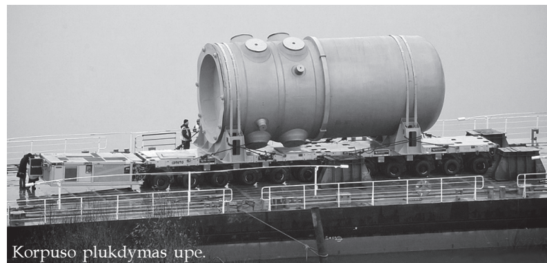
Pirmojo energetinio bloko reaktoriaus korpuso pakrovimas į baržą.
