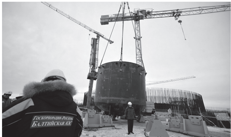
Išsilydžiusio kuro lokalizacijai skirto įrenginio, arba „gaudyklės“, korpusas (svoris 120 t), kurį sumontavo būsimo pirmojo energetinio bloko statinio centre, apačioje. Virš jo paskui statomas reaktorius. 2012 12 29
