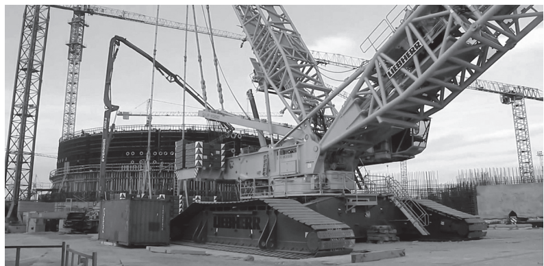
Astravo AE statybos aikštelėje montuojamas kranas „Liebherr“.
